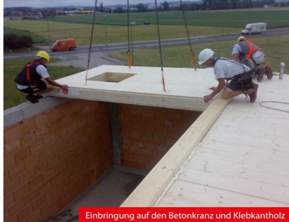
Einbringung auf den Betonkranz und Klebkantholz
